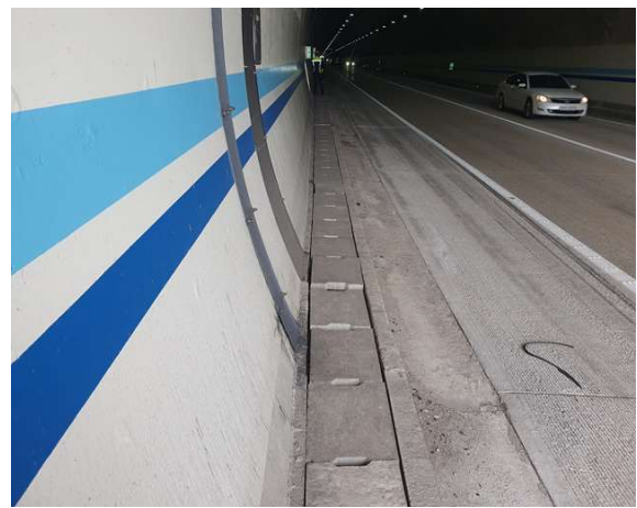
위 치 공동구 현 황 전경
