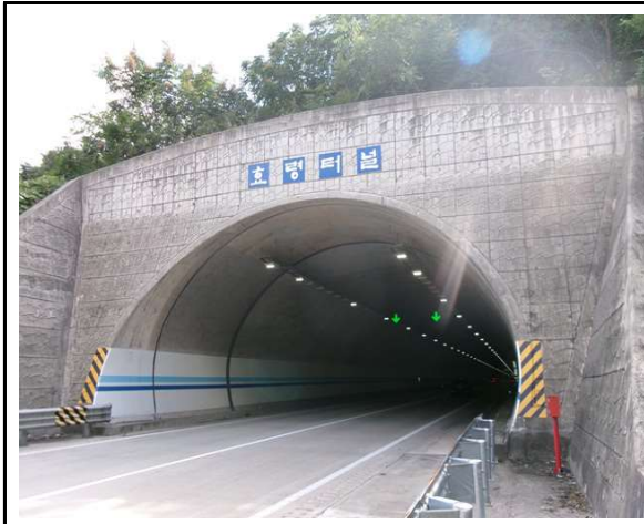
위 치 갱문 현 황 시점부 전경
