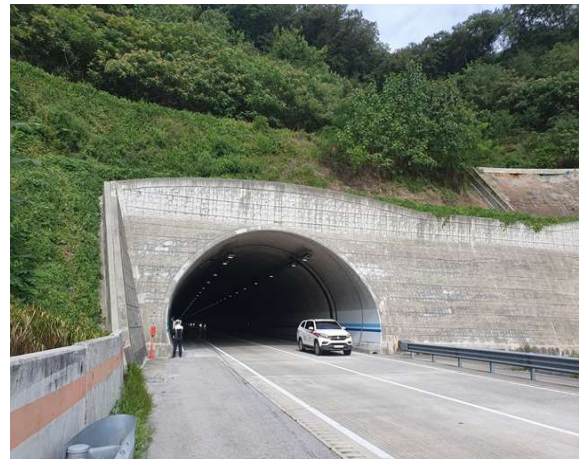
위 치 갱문 현 황 중점부 전경
