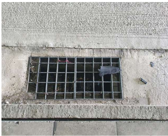
위 치 배수시설 현 황 전경
