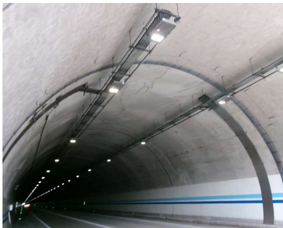
위 치 천단부 현 황 전경
